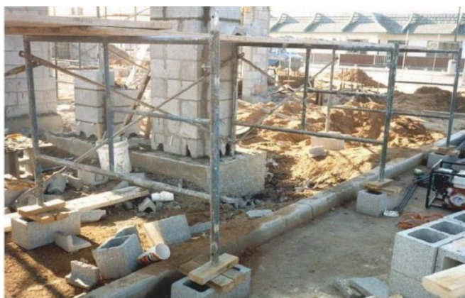
شکل ۱۰- لنگر یا مهاربند داربست پیچی
